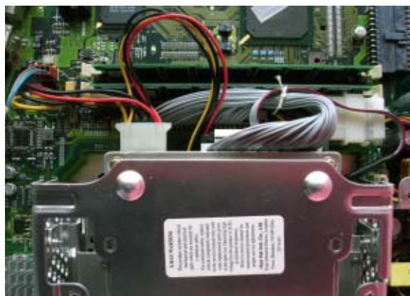
23. detail vyvázané kabeláže
