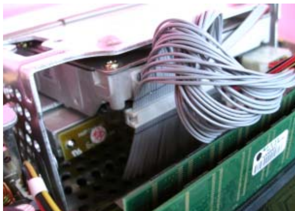
25. jiný pohled, konektory jsou ještě bez vytahovacích pásků a datový kabel není vyvázaný
